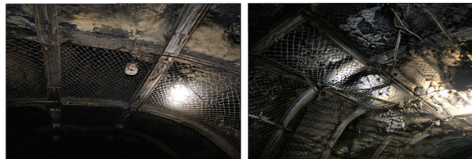
Рис. 7. Слой торкрет-бетона с сеткой для изоляции стыков в затяжке из круглого леса.
