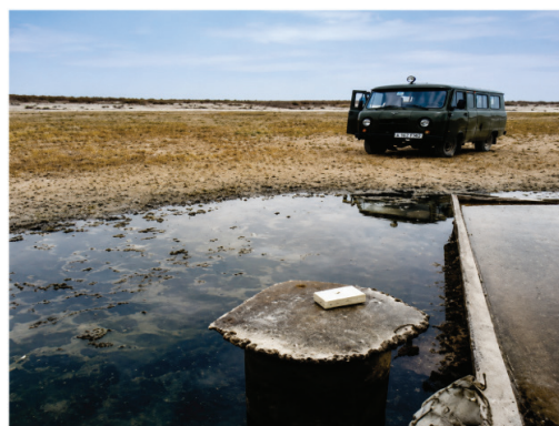
Сурет 1г. Өздігінен ағатын ұңғыманы тексеру. Figure 1d. Examination of a self-flowing well. Рис. 1г. Обследование самоизливающейся скважины.
