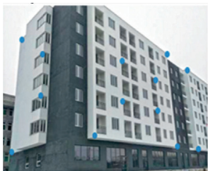
а) Контрольные марки, мониторинговые призмы и осадочные марки установленные на здании
