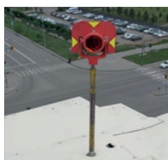
в) Мониторинговые точки на стенах здания
