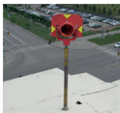
в) Мониторинговые точки на стенах здания
