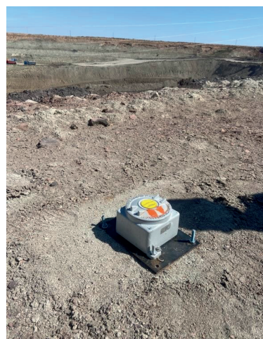
Рис. 1. Установленный виброметр в рабочем состоянии. Сурет 1. Жұмыс күйінде орнатылған виброметр. Figure 1. Installed vibrometer in working condition.
