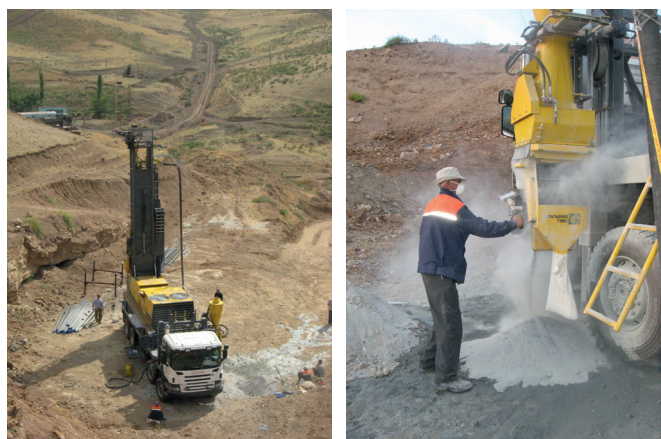
Рис. 1. Самоходная буровая установка Explorac-220RC компании Atlas Copco (Швеция) в процессе бурения геолого-разведочных скважин сжатым воздухом с использованием двойной бурильной колонны в сложных геологических условиях вблизи г. Алмалык.
