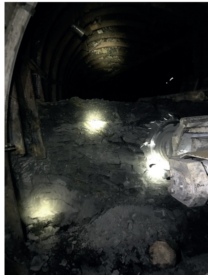
Рис. 1. Пучение почвы со дна выработки. Сурет 1. Қазба түбінен топырақтың ісінуі. Figure 1. Floor heave from the mine working bottom.
