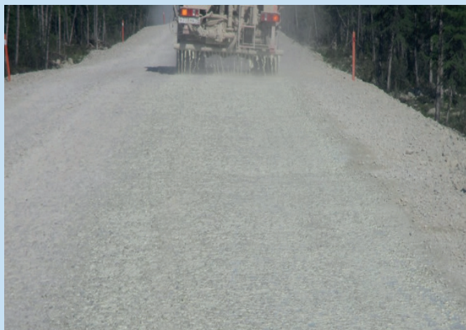
Рис. 4. Вид грунтовой дороги, обработанной ПВЭ «Эквипол (ТМ)».
