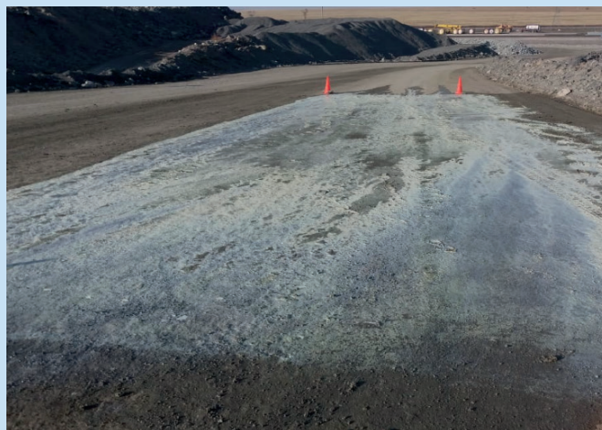
Рис. 4. Вид грунтовой дороги, обработанной ПВЭ «Эквипол (ТМ)».
