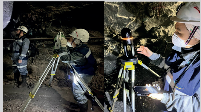
Рис. 2. Порядок выполнения работ:
