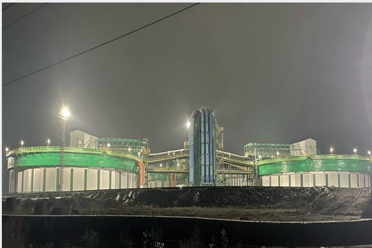
Рис.1. Комплекс сгущения хвостовой пульпы на ЮГОКе. Сурет 1. Оңтүстіктегі каудальды целлюлозаны қоюландыру кешені ОТКБК-да. Fig. 1. Tail pulp thickening complex in SM&PP.
