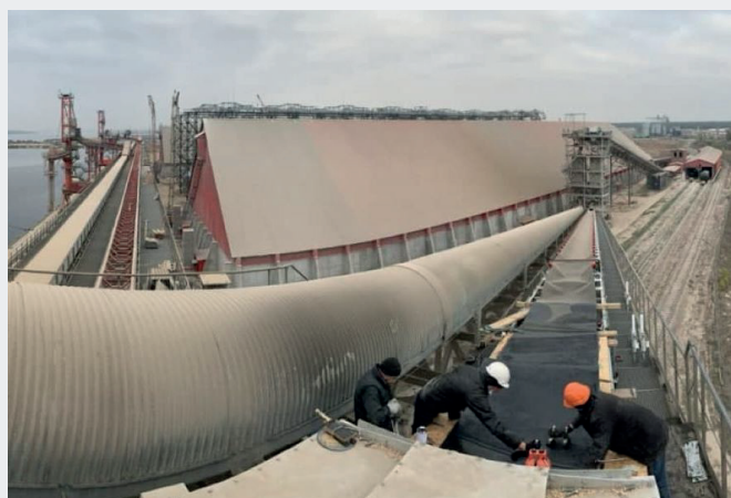
Рис. 3. Строительство концевой галереи через главную дорогу [1].
