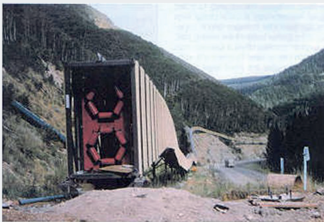
Рис. 4. Типичное поперечное сечение фермы с изображением направляющих роликов, полностью закрытых от налипания снега и льда [1]. Сурет 4. Қар мен мұздың жабысуынан толығымен жабылған бағыттаушы роликтер бейнеленген әдеттегі ферма көлденең кимасы [1]. Figure 4. A typical cross-section of the truss with the image of guide rollers completely closed from the sticking of snow and ice [1].
