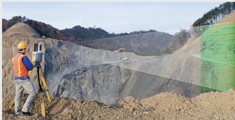
**Рис. 1. Лазерное сканирование карьерных откосов.**
