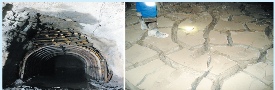
Сурет 3. Тау сілімінің сулануы (Жомарт кеніші). Figure 3. Wetting of the mountain range (Zhomart mine). Рис. 3. Обводнение горного массива (рудник Жомарт).
