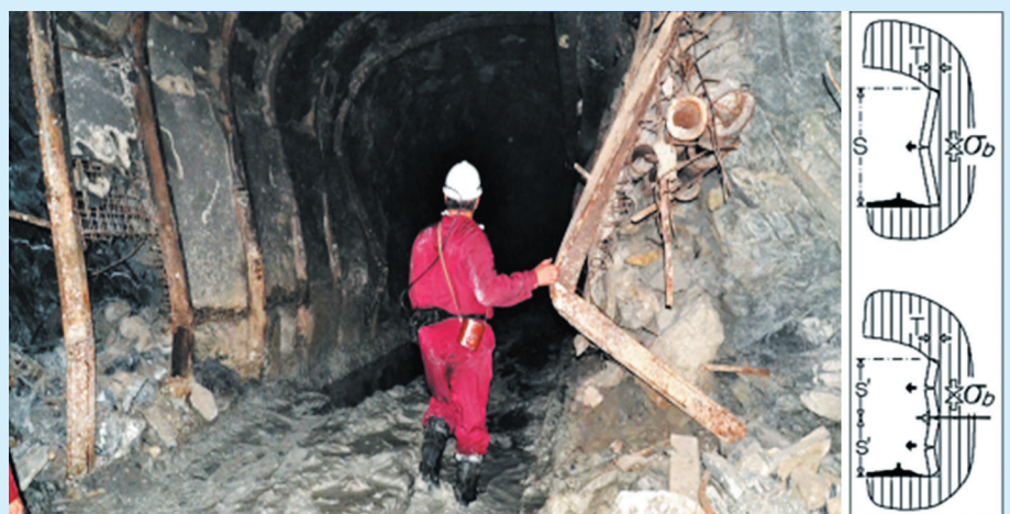
Сурет 4. Тігінен тақтатастану бойымен жыныстардың басылуы (Тишинск кеніші). Figure 4. Pressing of rocks along the vertical shale (Tishinsky mine). Рис. 4. Уплотнение породы вдоль вертикального сланца (Тишинский рудник).
