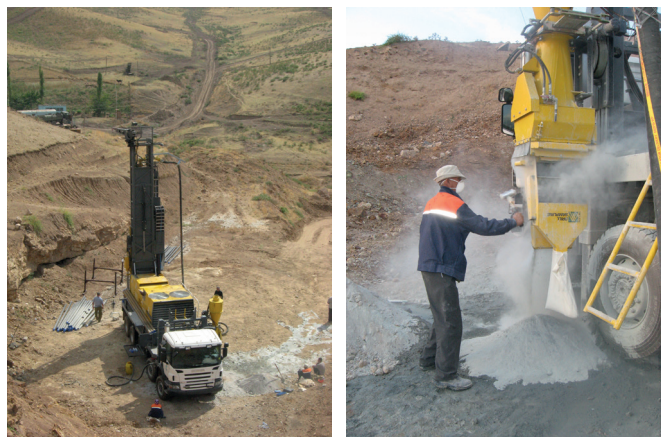
Рис. 1. Самоходная буровая установка Explorac-220RC компании Atlas Copco (Швеция) в процессе бурения геолого-разведочных скважин сжатым воздухом с использованием двойной бурильной колонны в сложных геологических условиях вблизи г. Алмалык.
