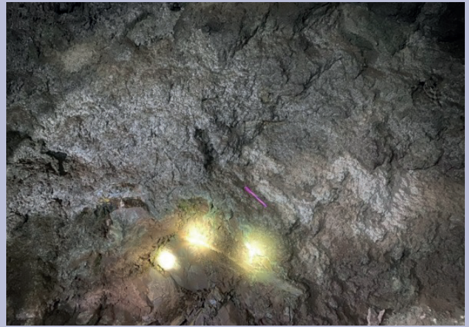
Рис. 1. Изображение трещиноватости массива месторождения Итауз.
