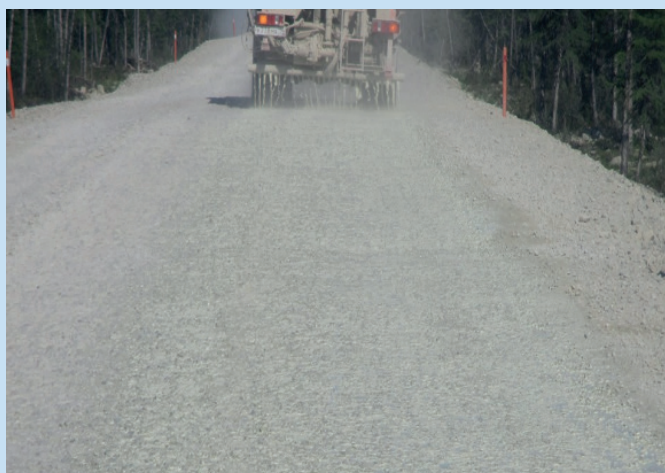
Рис. 4. Вид грунтовой дороги, обработанной ПВЭ «Эквипол (ТМ)».
