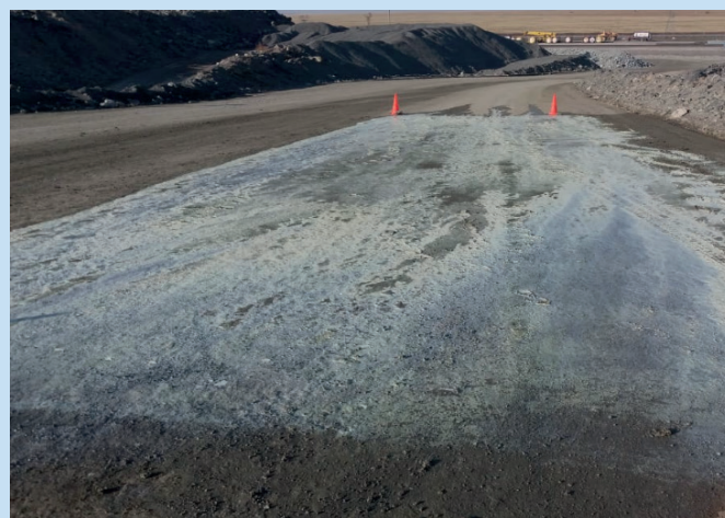
Рис. 4. Вид грунтовой дороги, обработанной ПВЭ «Эквипол (ТМ)».
