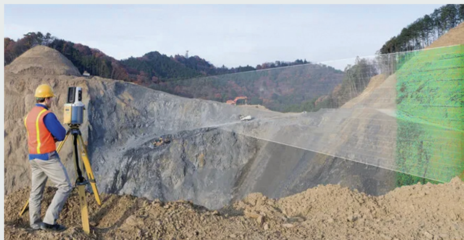
Рис. 1. Лазерное сканирование карьерных откосов. Сурет 1. Ашық карьерлерді лазерлік сканерлеу. Figure 1. Laser scanning of open pit slopes.
