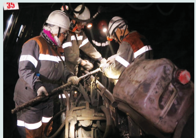
Рис. 1. Проверка целостности анкера. Сурет 1. Зәкірдің тұтастығын тексеру. Figure 1. Checking the integrity of the anchor.
