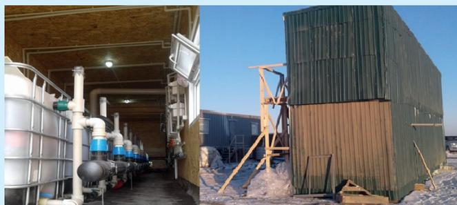
**Рис. 1. Общий вид установки бактериального окисления железа-1 изнутри и снаружи.**
