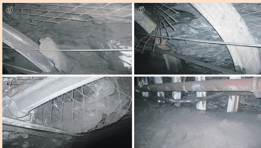
а – бүйір жыныстарының опырылысы; б – бүйірдің деформациясы; в – төбе жыныстарының деформациясы; г – табанның ісінуі
