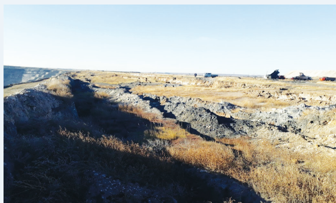
Рис. 1. Трещины разрыва вследствие нарушения устойчивости борта разреза.
