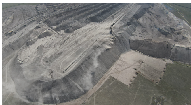
Рис. 1. Удаление слабого слоя на площадке формирования первого яруса отвала «Конвейерный» разреза «Восточный» – ФАО «ЕЭК».
