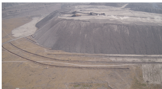
Рис. 2. Устройство противооползневых выемок специальной формы.
