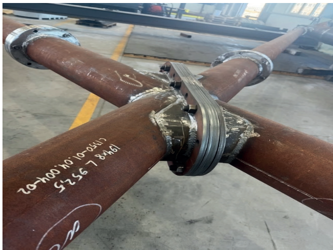
Рис. 2. Контроль сборки металлоконструкции стрелы шагающего экскаватора ЭШ 13/50.
