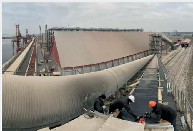
**Рис. 3. Строительство концевой галереи через главную дорогу [1].**
