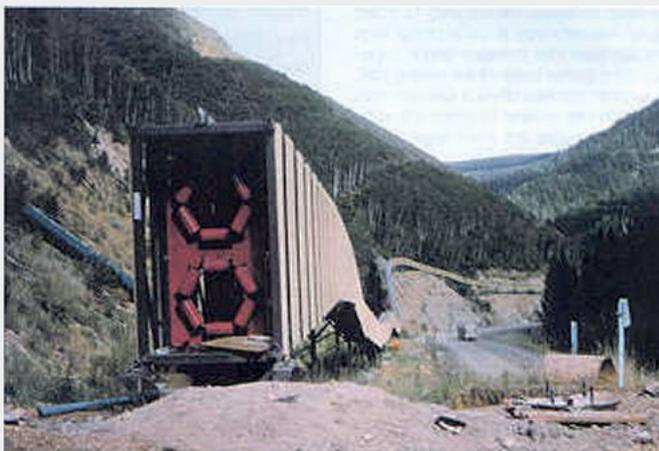
**Рис. 4. Типичное поперечное сечение фермы с изображением направляющих роликов, полностью закрытых от налипания снега и льда [1].**
