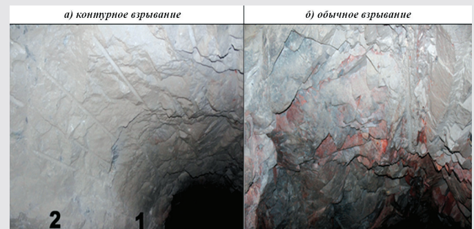
Рис. 7. Влияние силы взрыва на кровлю выработки. Сурет 7. Сурет-қазба шатырына жарылыс күшінің әсері. Figure 7. Effect of the explosion force on the roof of the workings figure.
